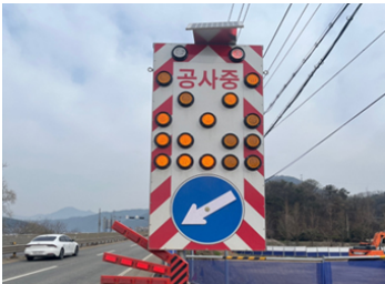
태양광 점멸식 교통안전시설
