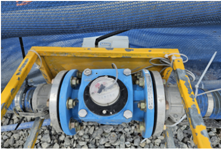
원격 검침 유량계 설치
