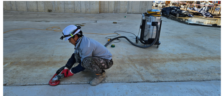
야외 연마 시 집진기 설치
