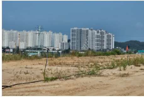
주통로 성토면 스프링클러 설치
