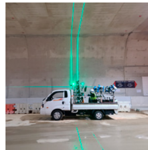
경부동탄 1공구 균열검사 과정
